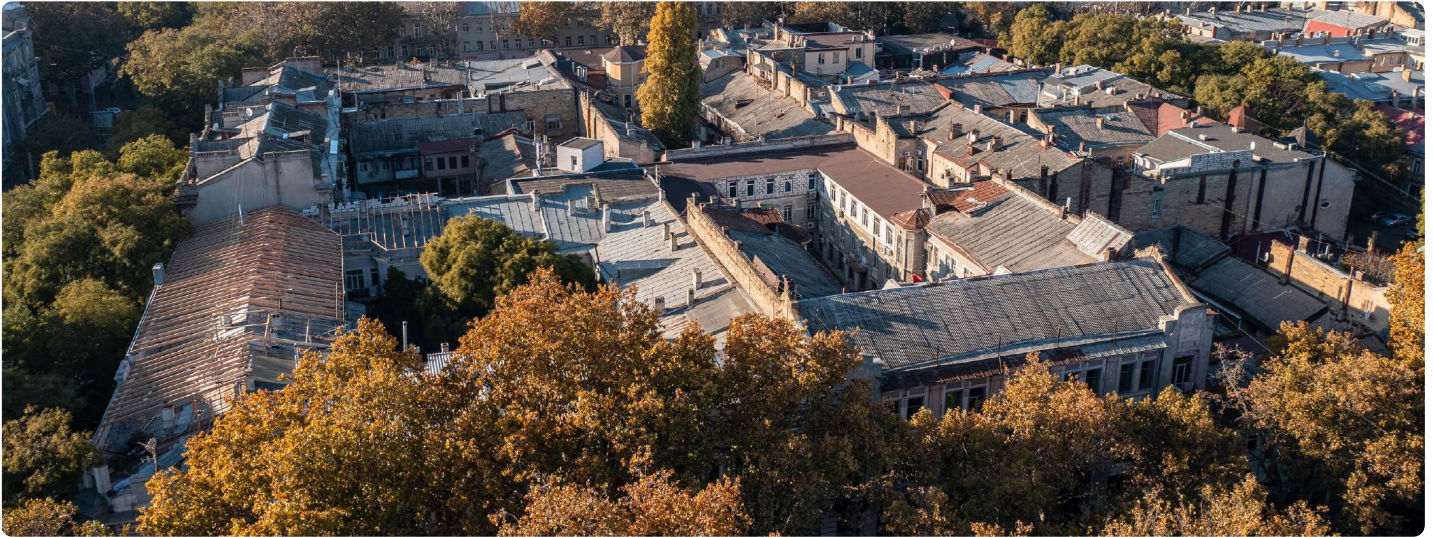
Покрівля історичної забудови. Сучасний стан
