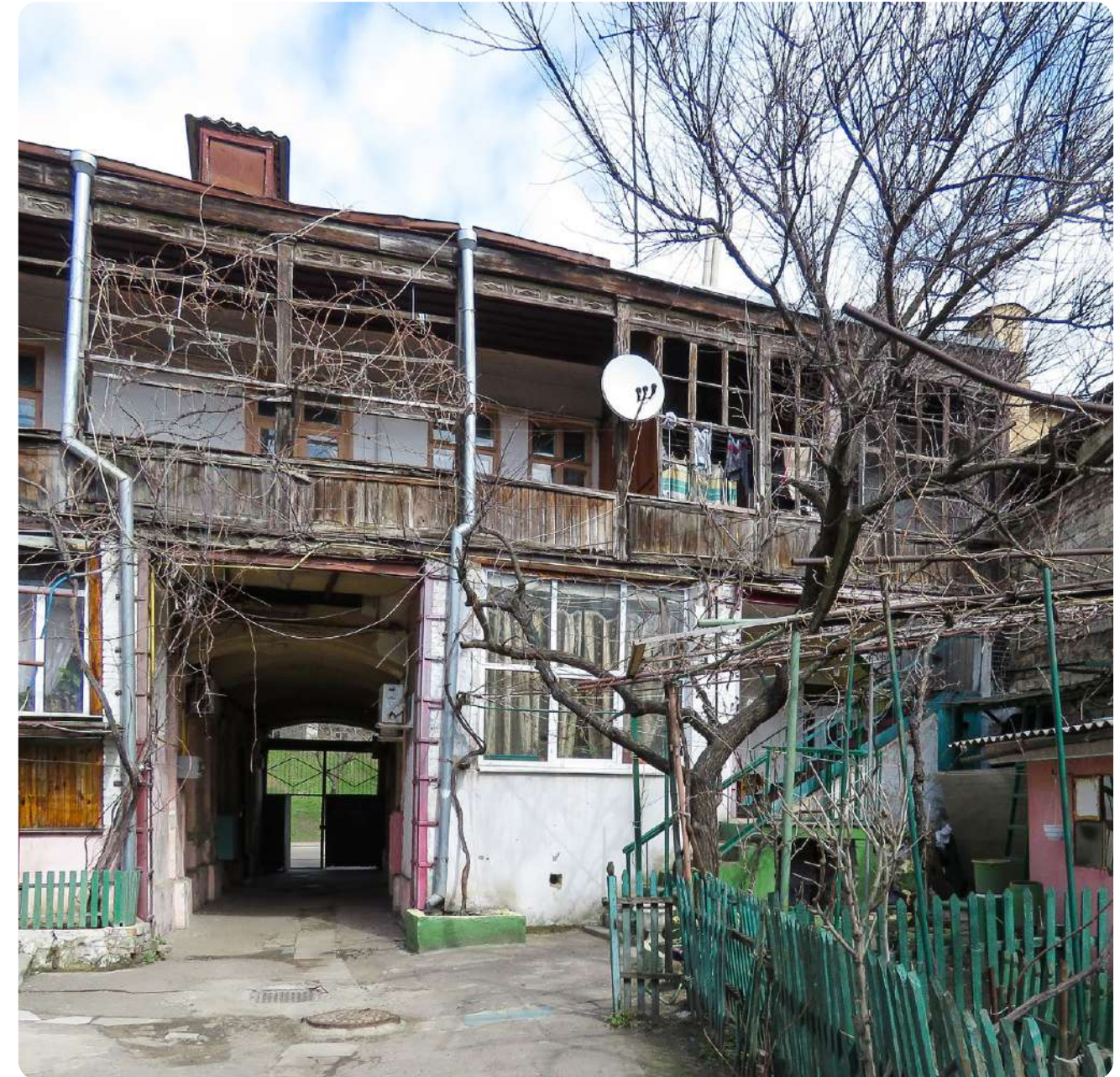
Дерев'яні елементи галереї, що збереглися та чекають реставрації
