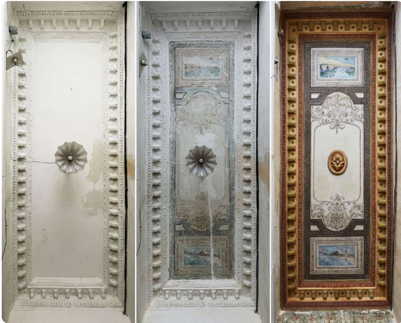
Етапи відновлення розпису на стелі будинку Балашева по Лютеранському пров., 3. Проект реалізований спільнокоштом зусиллями ГО «Архітектура Одеси»
